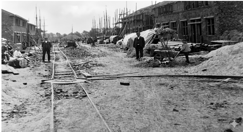
Tulpenstraat in aanbouw
