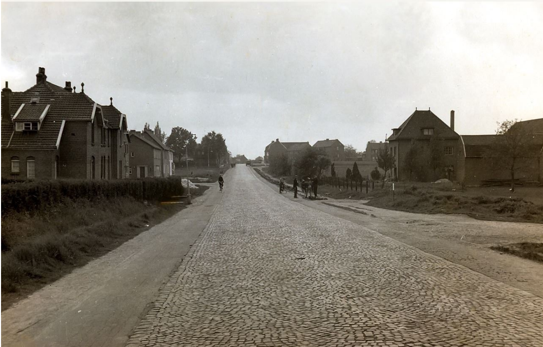
Kaalheidersteenweg ter hoogte van de Tulpenstraat (ter hoogte van de fietser links) Aan de rechterkant voorbereidende werkzaamheden t.b.v. aanleg tram.
